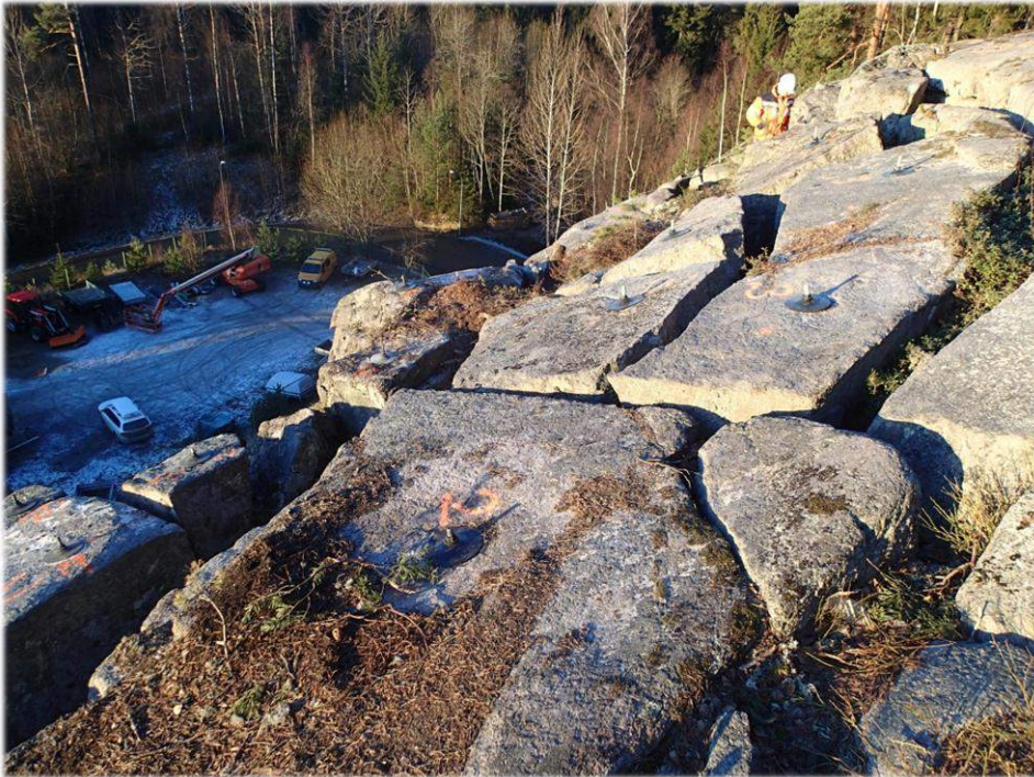
Løse steinblokker over en tilkomstvei til et boligområde i Drammen er nettopp sikret.
