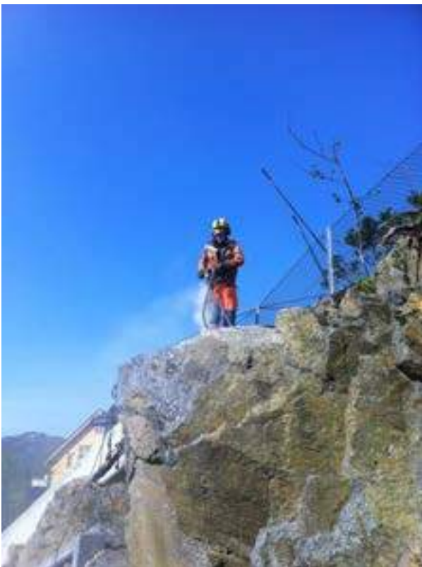
Standardboring (venstre bilde) og boring med håndjekk (høyre bilde), Sjøkrigsskolevegen.
