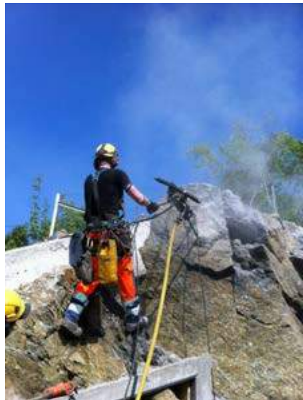
Standardboring (venstre bilde) og boring med håndjekk (høyre bilde), Sjøkrigsskolevegen.
