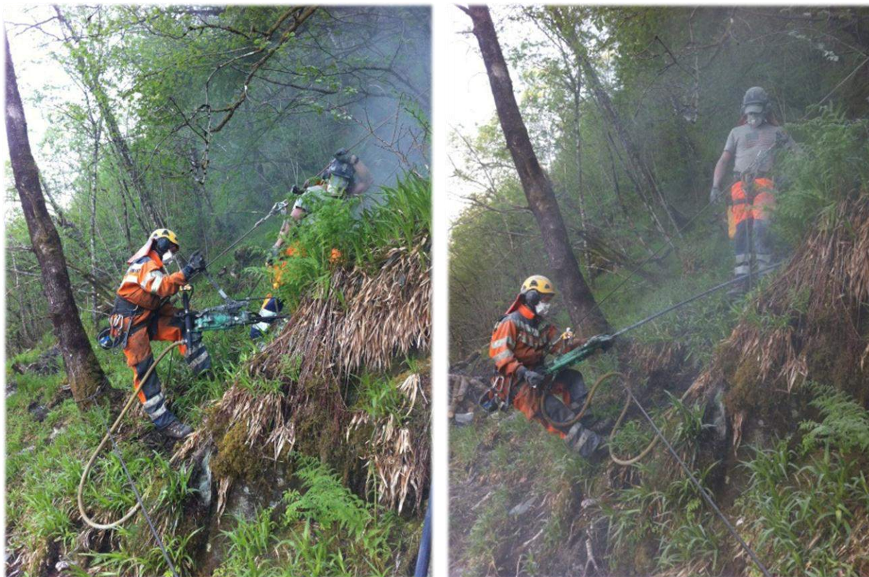
Boring ved hjelp av håndjekkjekk på Trengereid
